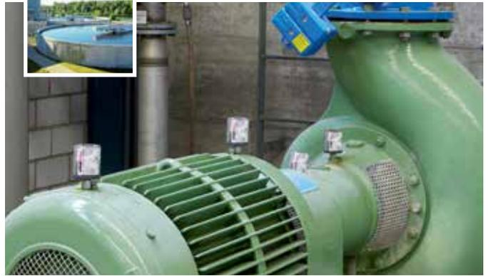
El lubricador de 60 ml en el motor eléctrico y en el eje de transmisión asegura la lubricación continua de una bomba centrífuga.
