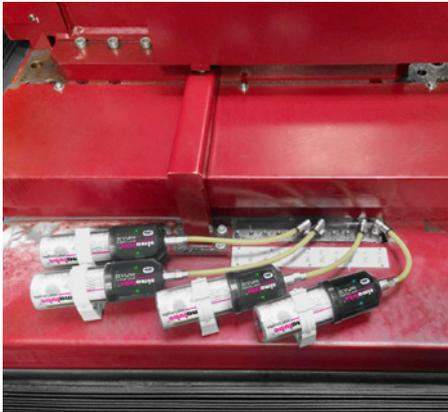
4個小保姆智能藍牙增壓泵經管道連接CNC數控機床直線導軌上的潤滑點, 通過simatec應用軟件APP配對每一個獨立的增壓泵來監控各自潤滑工況
