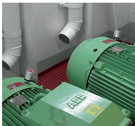
Les moteurs électriques d'ABB sont équipés de graisseurs simalube de 60 ml.
