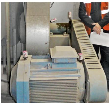
Une soufflerie d'incinérateur lubrifiée par deux graisseurs simalube de 60 ml et 125 ml.
