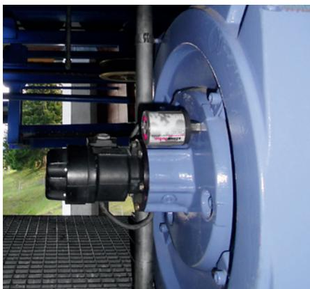
El motor de una telecabina de la estación de montaña se lubrica continuamente con un lubricador automático de 60 ml.
