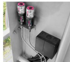
Aufgrund fest installierter Schmierleitungen an einem Beckenräumer kommen zwei simalube IMPULSE connect zum Einsatz. Sie überwinden den Gegendruck und sorgen für eine kontinuierliche Schmierung.
