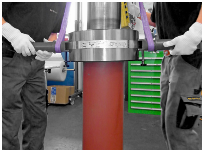
Das vorgewärmte schwere Pendelrollenlager lässt sich mit dem Bearing Handling Tool BHT sicher heben und kontrolliert über der Turbinenwelle montieren.
