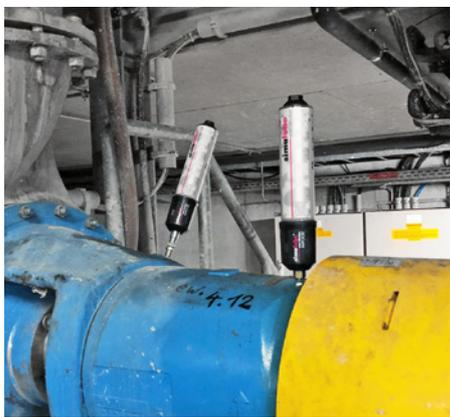
El rodamiento de la bomba se lubrica con dos IMPULSE y simalube de 250 ml.
