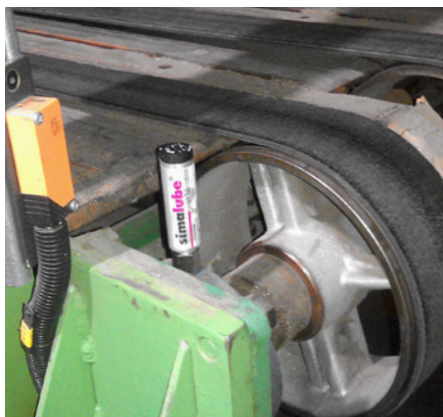
Dans les usines de carton ondulé, les paliers des bandes transporteuses sont continuellement lubrifiés avec le graisseur simalube.
