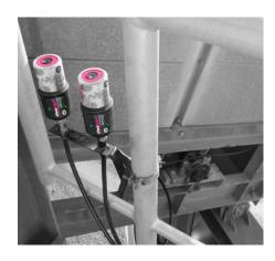
Les points de graissage se trouvent à une hauteur dangereuse. Grâce à l'application simatec, il est possible de les contrôler aisement depuis le sol.
