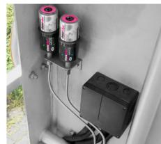
Deux simalube IMPULSE connect sont installés sur des conduites rigides d'un racloir de bassin de décantation. Ils surmontent la contre-pression et assurent une lubrification continue.
